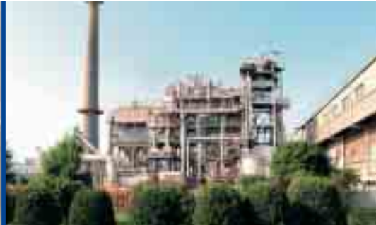
シュレッダーダスト再資源化施設
