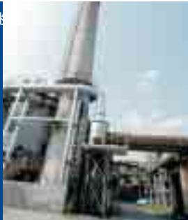
使用を停止した社内焼却炉
