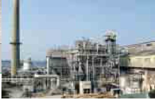
シュレッダーダスト再資源化施設
