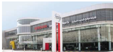
2007年6月 カタールにショールームをオープン
