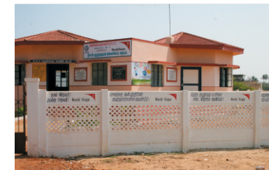
被災した子どもたちを支援する施設の建設に協力(インド)
