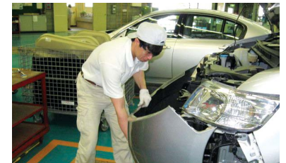
解体実証実験風景
