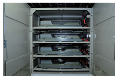
「日産リーフ」4台分のリチウムイオンバッテリーを使用した蓄電装置
