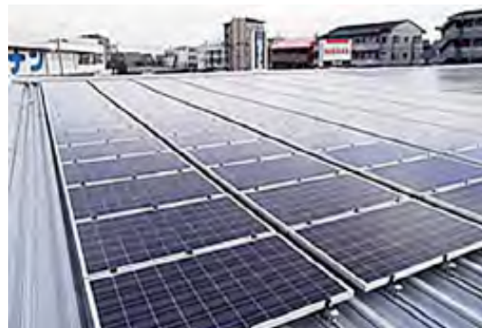
神奈川県日産自動車(株)の一部の販売店の屋根に設置した太陽光パネル。得られた電力を日産PPSとして調達し販売店に供給しています
