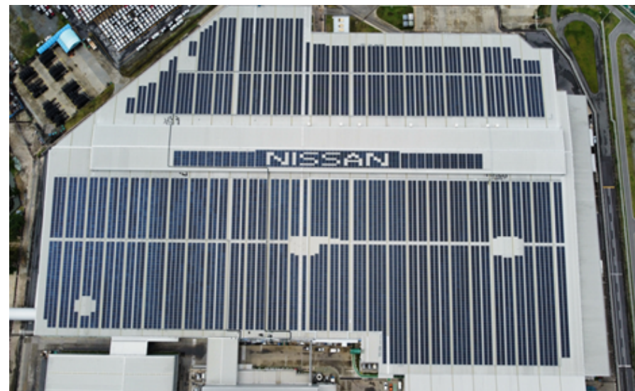
タイ工場の5.5MWの太陽光発電
